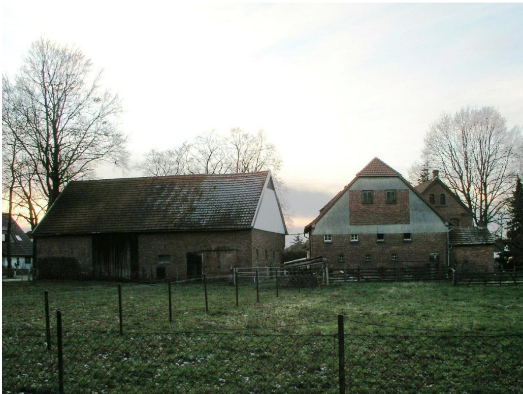
Abb. 1 Hofstelle Degener Gütersloh; links zum Abriss vorgesehene Scheune, rechts zu erhaltendes Nebengebäude; Blick von Osten
