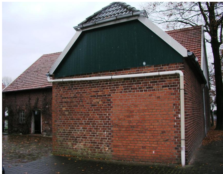
Abb. 8 Holzverkleidung des Westgiebels der Abbruchscheune als mögliches Fledermausquartier
