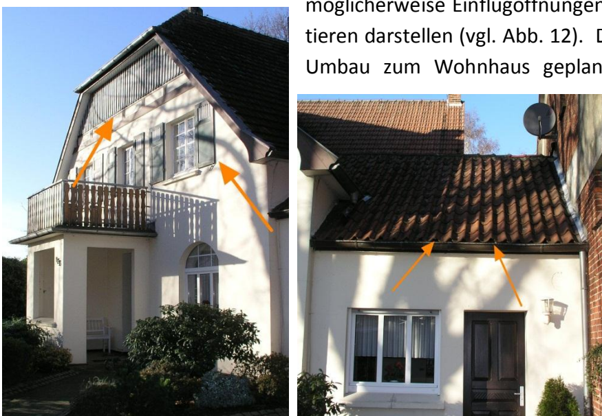
Abb.11 Mögliche Spaltenverstecke am Haupthaus und Anbau
