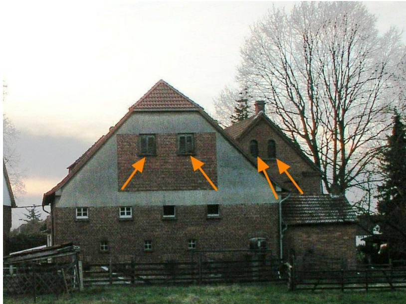
Abb.12 Mögliche Spaltenverstecke am Haupthaus und Anbau
