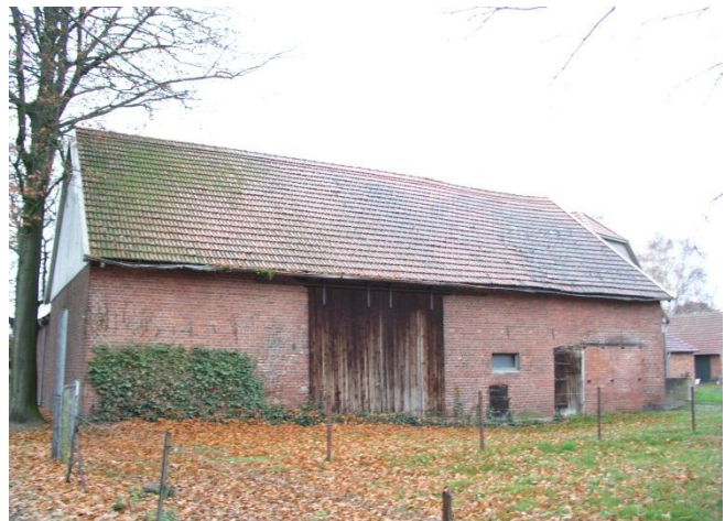
Abb. 3 Ostfassade der zum Abriss vorgesehenen Scheune
