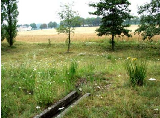
offene Betonrinne an der Böschung der Versickerungsmulde
