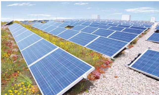
Dachbegrünung mit Photovoltaikmodulen
