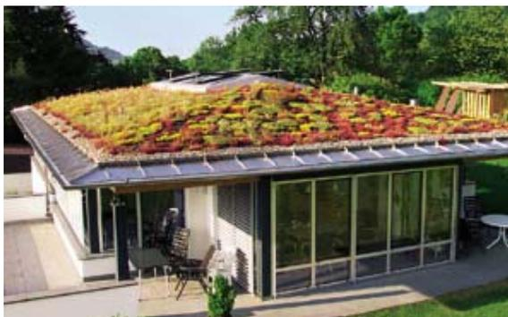
**Extensive Flach- und Schrägdachbegrünung (Quelle: [www.optigruen.de](http://www.optigruen.de))**
