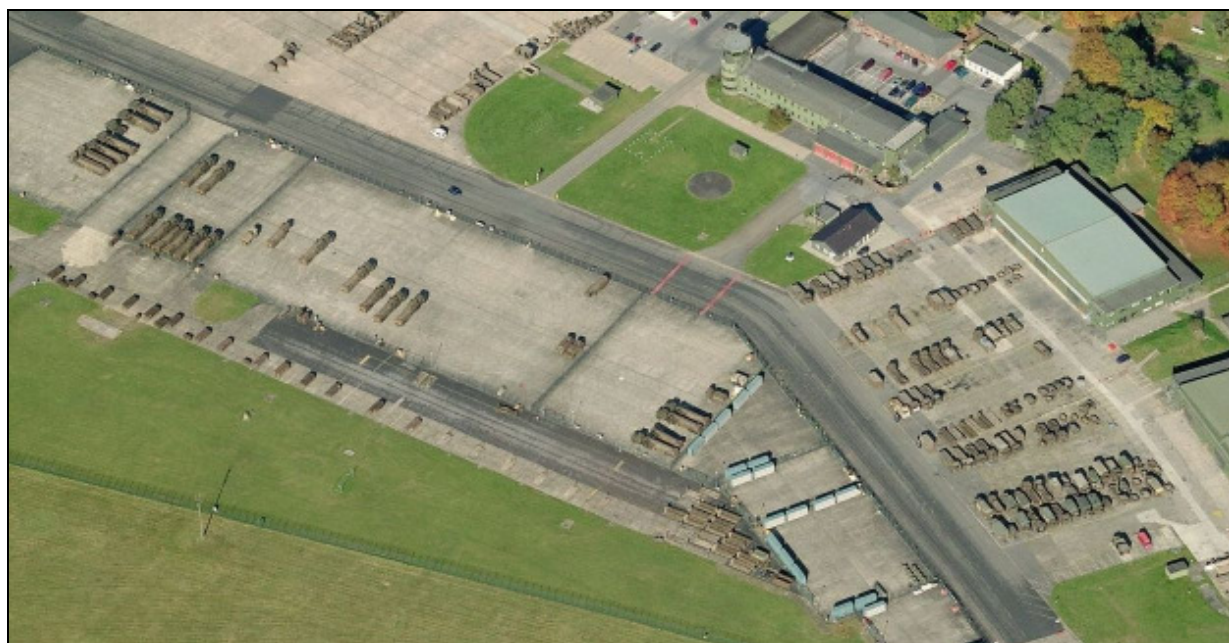
Abbildung 5: Vogelperspektive Flugplatz – ehemaliges Flugvorfeld mit Towergebäude – (Quelle: Bing Maps, www.bing.com/maps )
