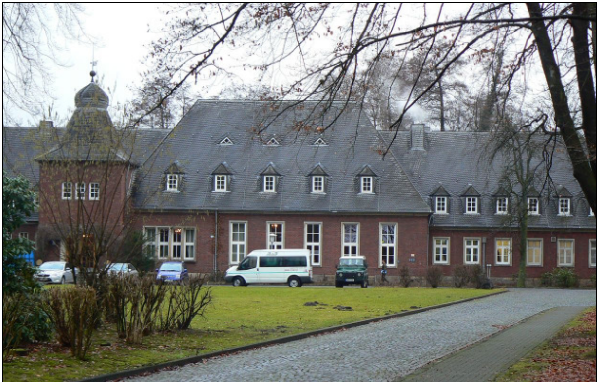
Abbildung 19: Foto Kaserne – Offizierskasino –
