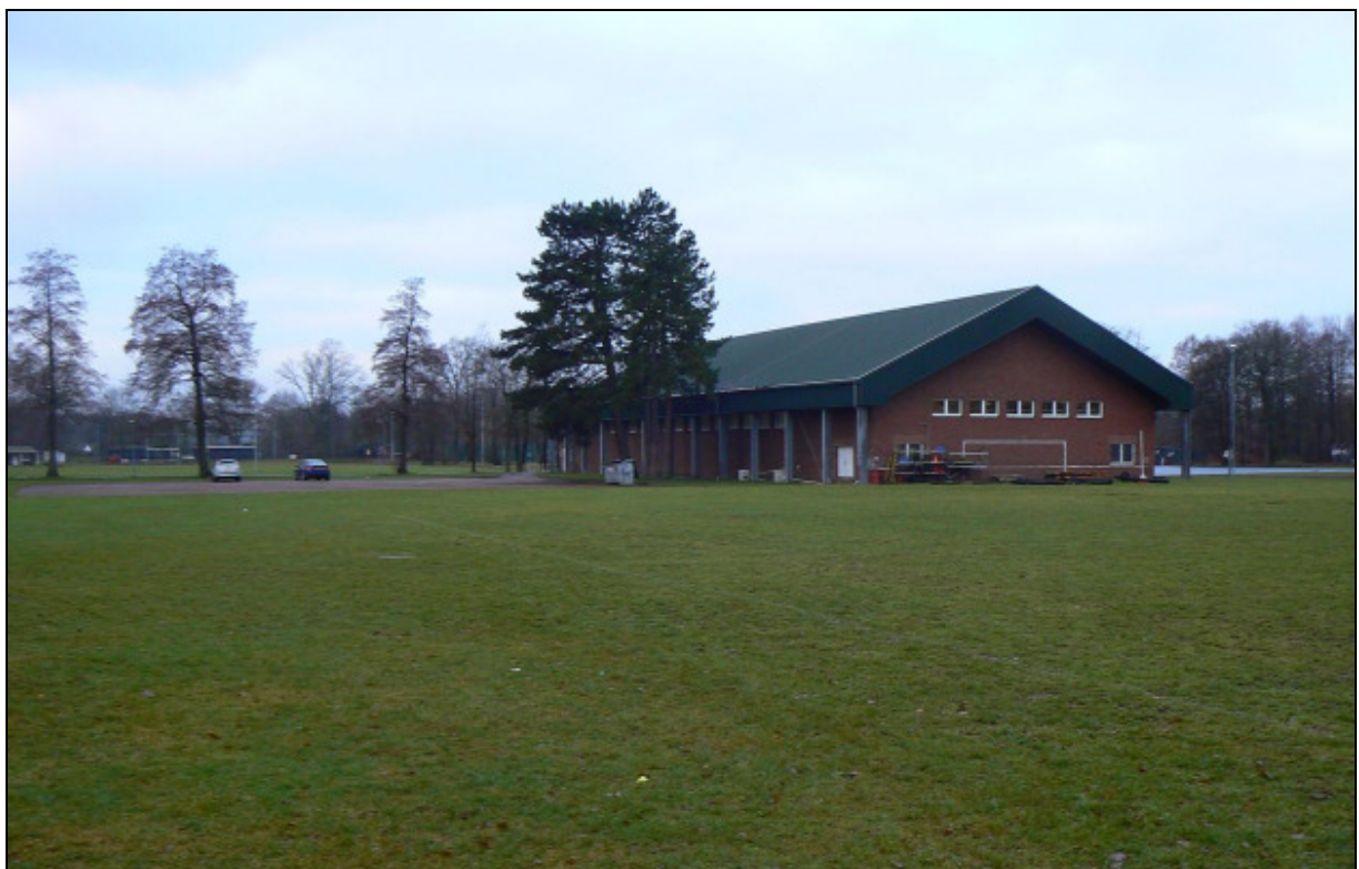
Abbildung 22: Foto Kaserne – Sportanlage im nördlichen Teilbereich –
